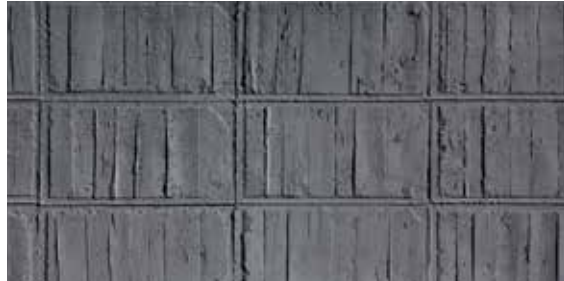
220 Concreto Grezzo Fume
